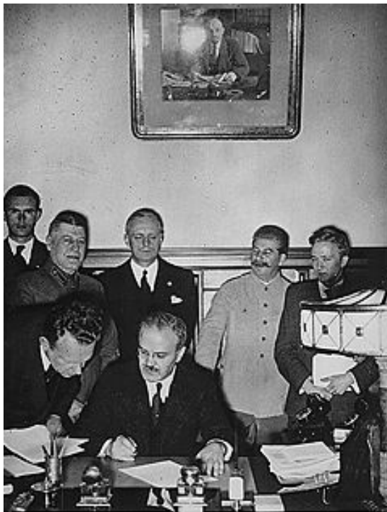
Fig. 11. Semnarea de către Joachim Von Ribbentrop, Iosif Stalin și alții a pactul Ribbentrop-Molotov pe 23 august 1939 (sursa: www.adevarul.ro ).
